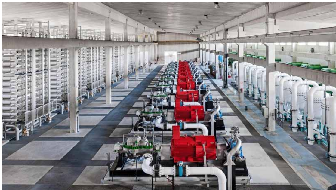
Planta de desalación de Cox. Cedida.
