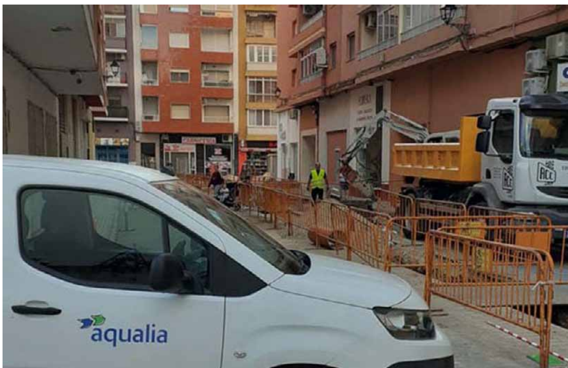
Las obras ya han empezado en la calle Senija.
