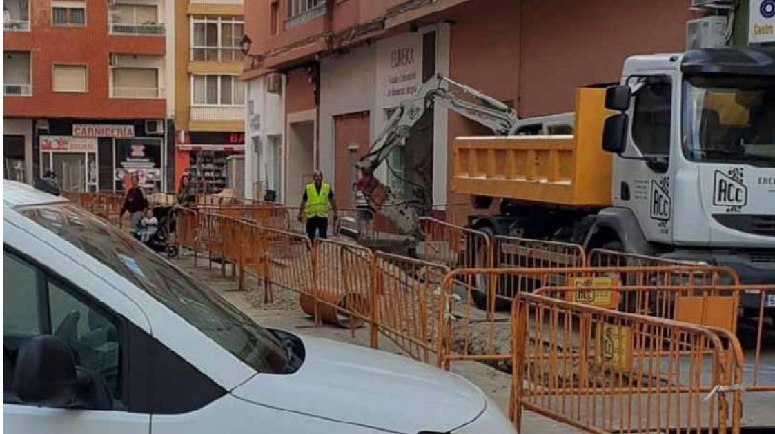
Calle Senija durante las actuaciones de saneamiento del alcantarillado y red de agua potable en Dénia. / Levante-EMV
